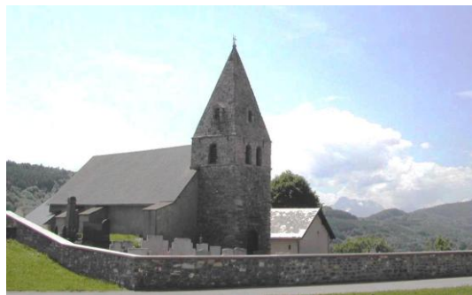
Eglise de St Jean de Vaulx (PV)
